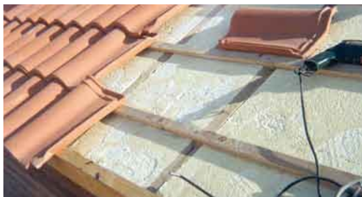
Rehabilitación en cubierta inclinada
